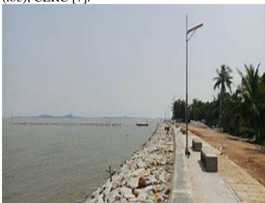
Gambar 1. Bangunan pelindung pantai ( revetment )
