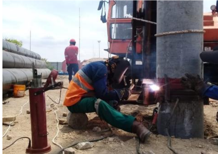
Gambar 2. Pengelasan Tiang Pancang
